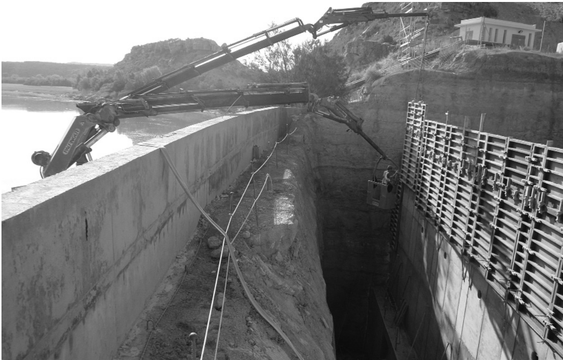
Imagen de las obras de instalación de la toma de agua en Escatrón. I. M.
